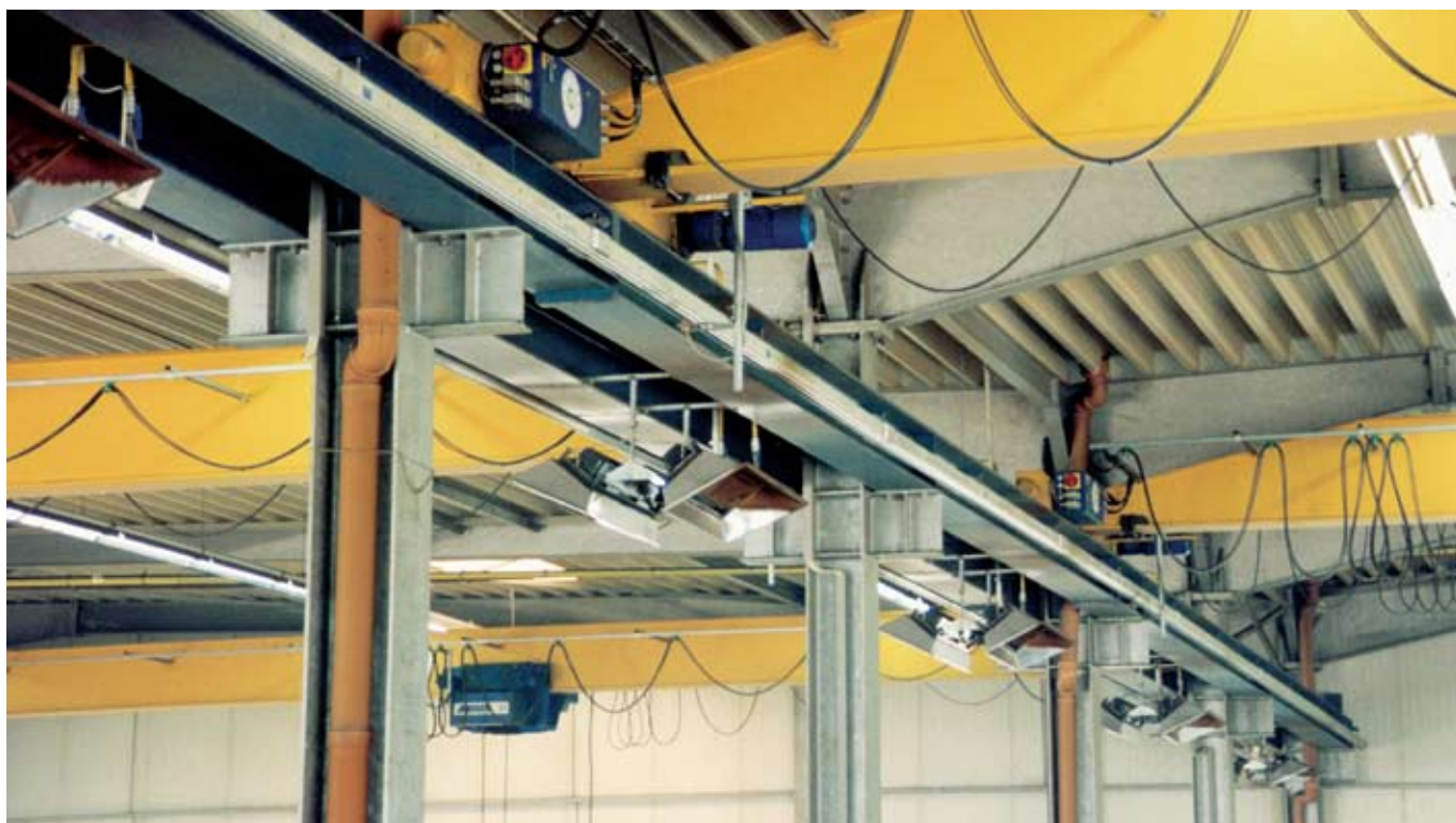
● Безопасный троллейный шинопровод LSV для цехового крана.
